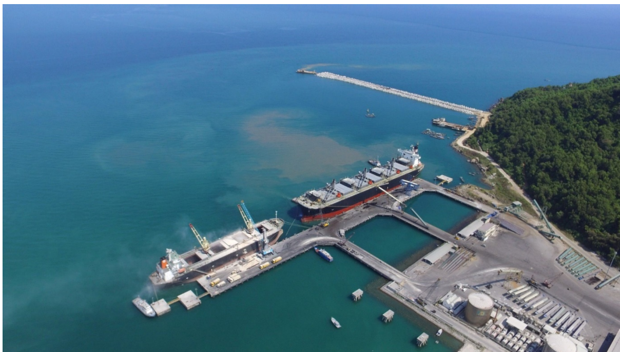
Hình ảnh: Hệ thống đê chắn sóng cảng Chân Mây được đầu tư xây dựng để đảm bảo an toàn cho các tàu thuyền có thể neo đậu trong vịnh.
